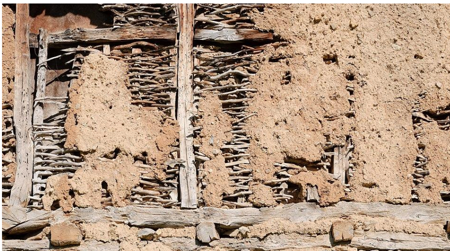
Äldre flätverk från 1800-talet där tidens tand gjort att flätverket åter är synligt, kloster i Bulgarien. Fotografi: Creative commons, user: MrPanyGoff. Återgiven utan ändringar under licens https://creativecommons.org/licenses/by-sa/4.0/deed.en
