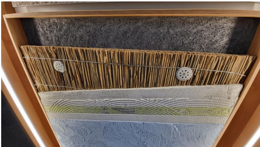
Idag finns det moderna tekniker för revertering. Exempel på skikt i reverterad vägg från branschutställning i Tyskland. Fotografi: Johan Jönsson.
