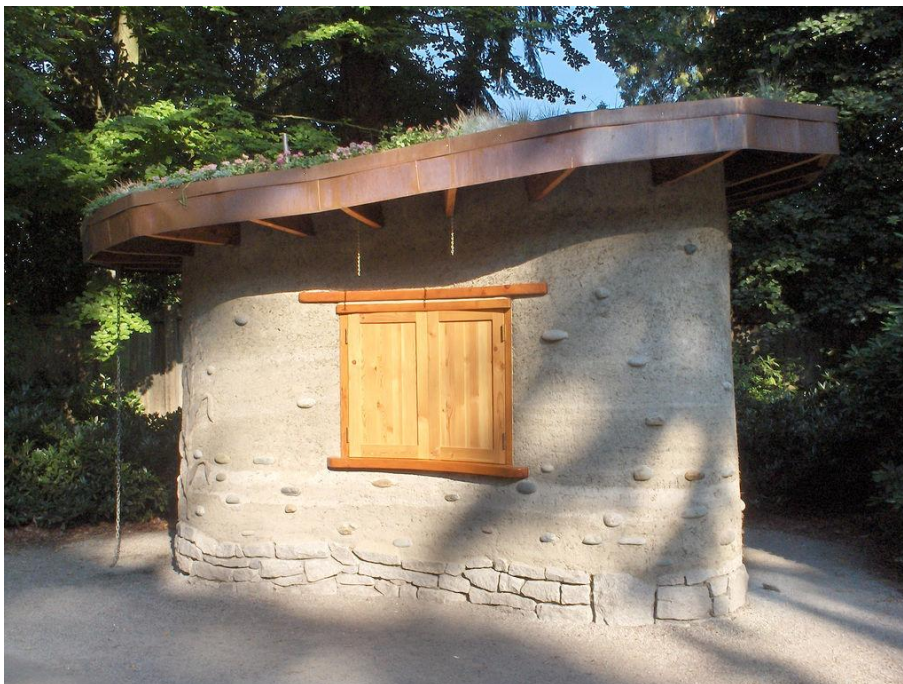
Cob house - kiosk uppförd med mackeleringsteknik, Stanley park, Vancouver, Kanada. Fotografi: Creative commons, user: Arifm. Återgiven utan ändringar under licens https://creativecommons.org/licenses/by/2.0/deed.en
