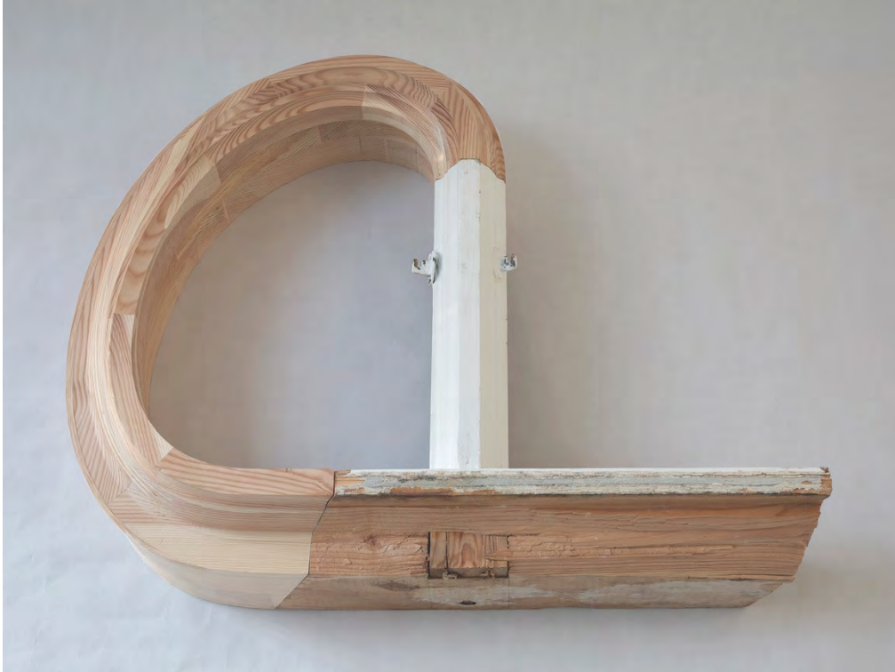
Fig. 6. "Komplettering" av avsågad fönsterkarm. Anpassning till snittytors geometri m h a CNC-fräst massiv furu.
