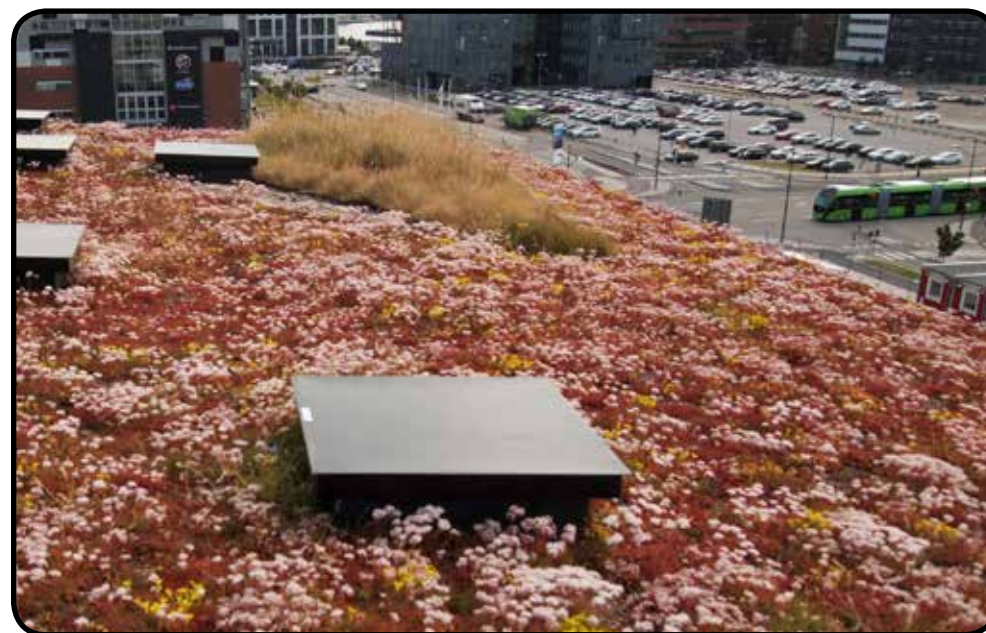
Foto: Lisa Berglind, Byggvesta, Klippern Västra Hamnen
